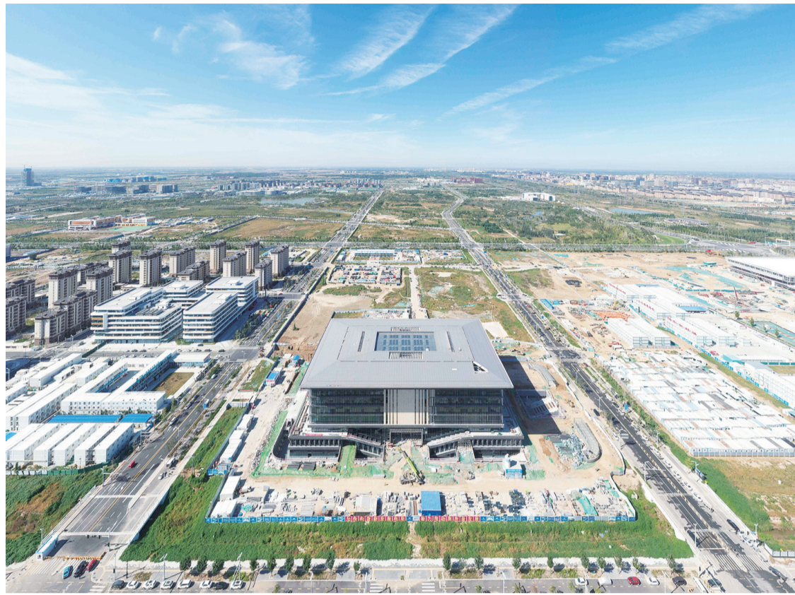
这是雄安新区大学园图书馆(2023年10月1日摄,无人机照片)。新华社记者 朱旭东 摄
